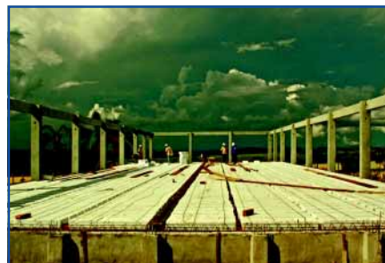
2007 / Janeiro Montagem e preenchimento da laje
