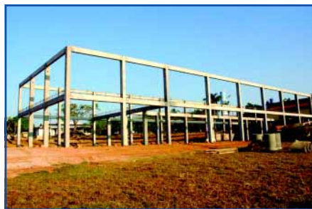
2006 / Agosto Montagem da estrutura pré-moldada
