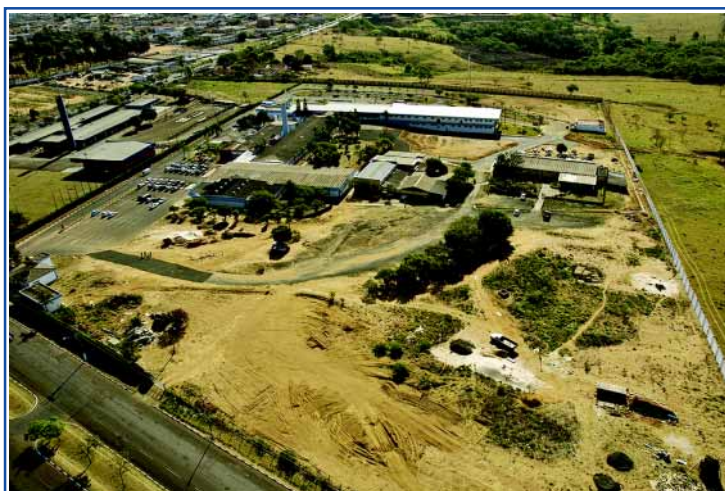
Área que abriga atualmente os Hospitais do Câncer, do Coração e Centro de Reabilitação (ao fundo). Em primeiro plano, podemos ver uma área livre que cederá lugar para futuras construções.
