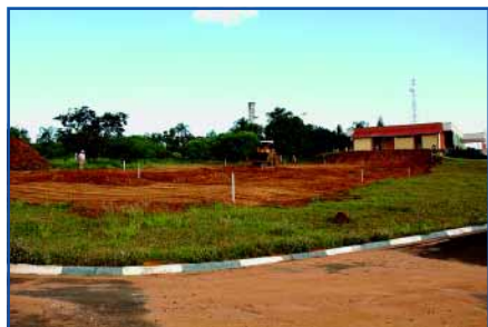
2006 / Abril Início da obra com terraplenagem
