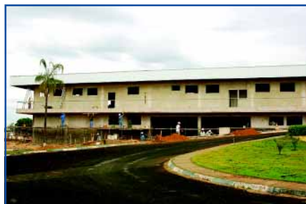
2007 / Maio Acabamento na parte externa e interna (pintura, instalações elétricas, etc.)
