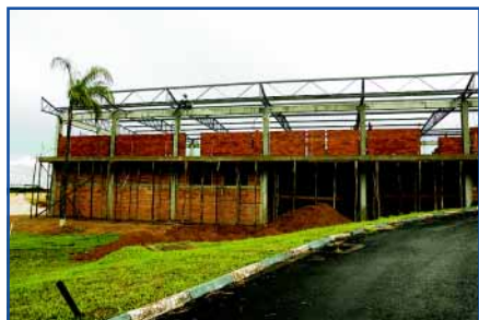
2007 / Fevereiro Levantamento das paredes e colocação das estruturas de ferro do telhado
